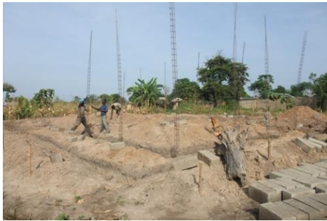
Die Baustelle wird eingerichtet
