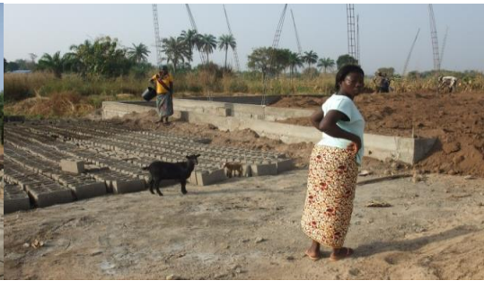
Parallel werden die Steine hergestellt
