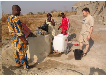
Vorab muss ein Brunnen gebaut werden
