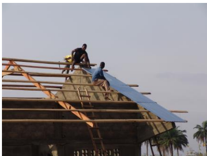
Das Wellblechdach wird montiert
